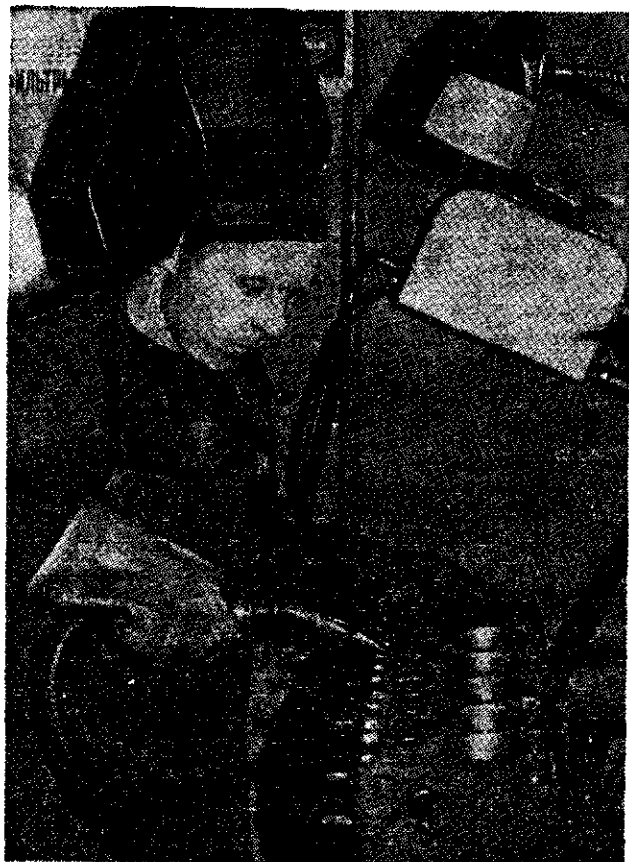
Рис. 12. Заварка трещины в блоке цилиндров автомобиля ГАЗ-52 проволокой ПАНЧ-11
