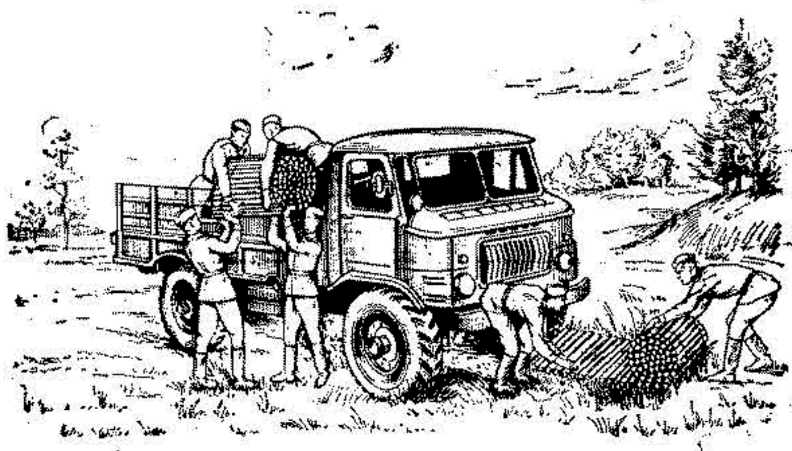
Рис. 16. Укладка kolejных дорожек из прутьев
