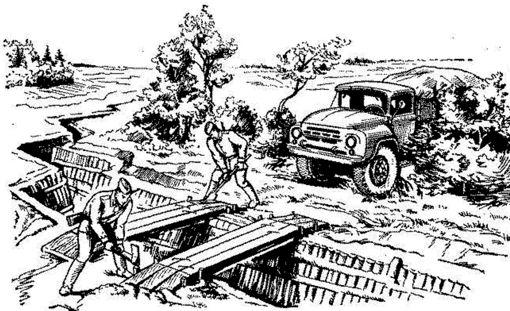
Рис. 15. Укладка kolejных мостиков через препятствие
